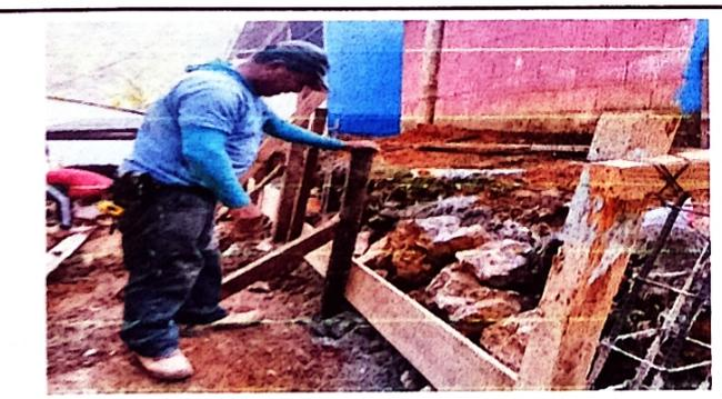
Foto 5: colocando el cimientto y levantamiento de la estructura con materiales de piedra del muro perimetral.
