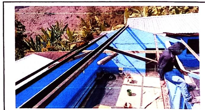
Foto 6: Destechando las láminas y costaneras de metal en mal estado de la bodega.
