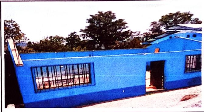
Foto 2: aula 2 ya destechado con láminas y costaneras de madera en mal estado.
