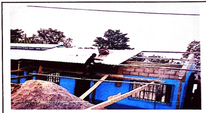
Foto 4: colocando las láminas y costaneras del aula 2.
